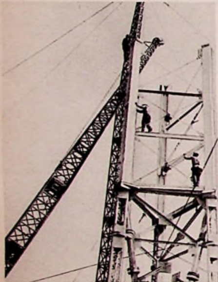
Montage des Turmunterteils
